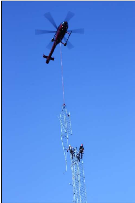
Figur 5 Helikopterlyft av mastsektion
