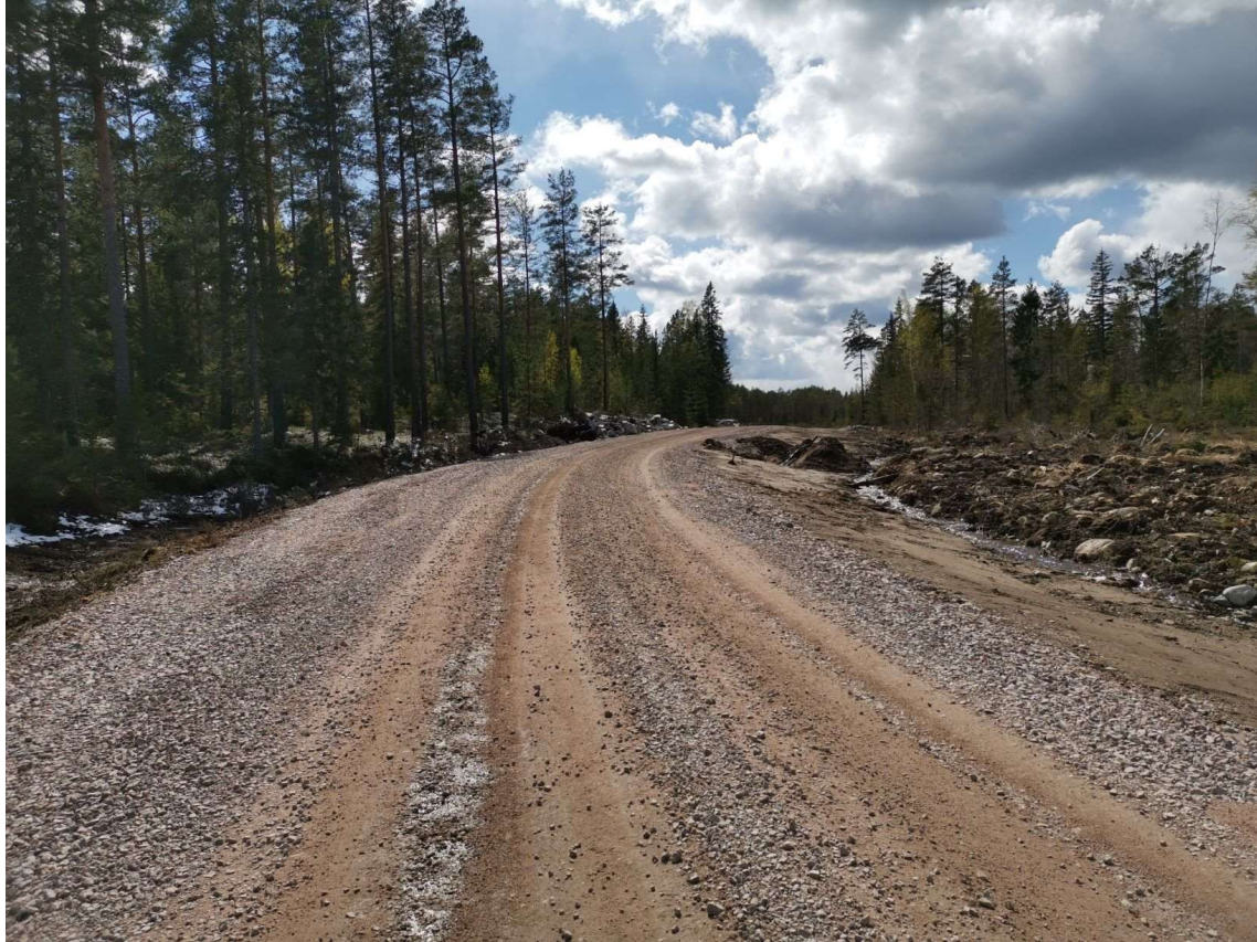
Figur 11 Nyanlagd väg i vindpark
