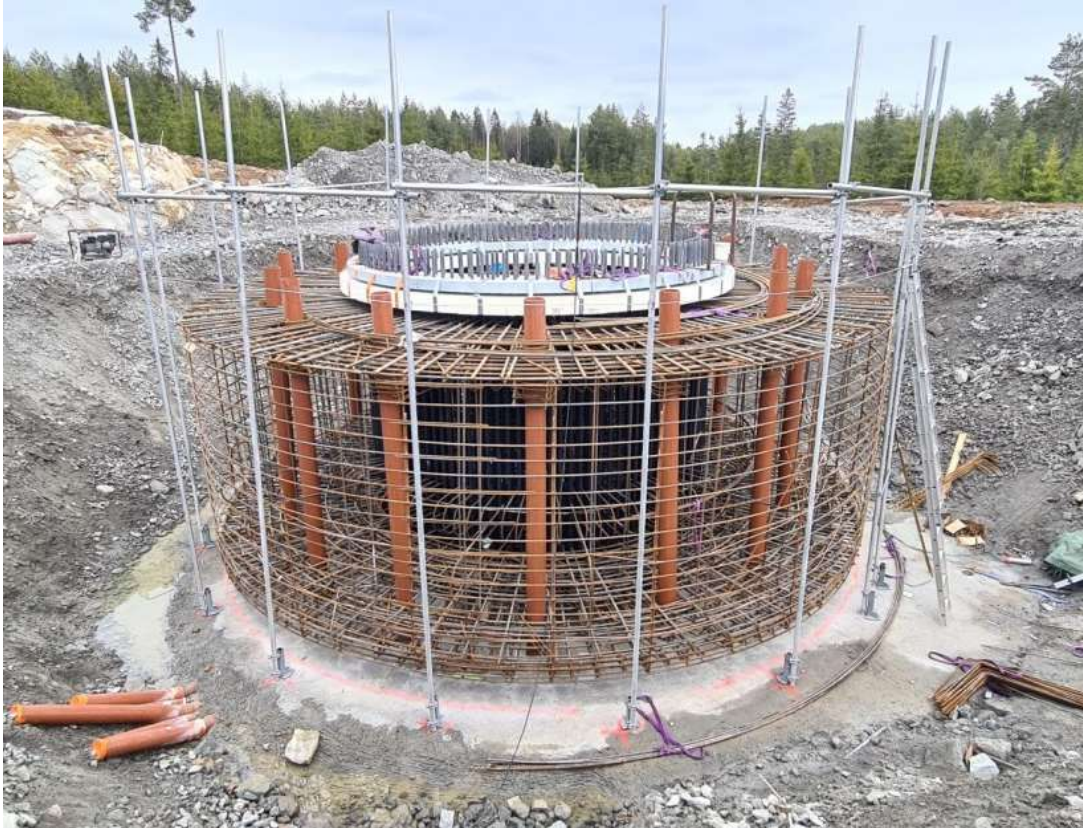
Figur 12 Pågående armeringsarbete på ett bergsförankrat fundament
