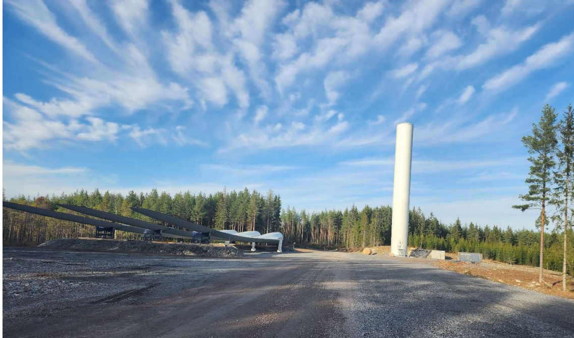
Figur 13 De första torndelarna är resta. Rotorblad väntar på installation på kranytan.
