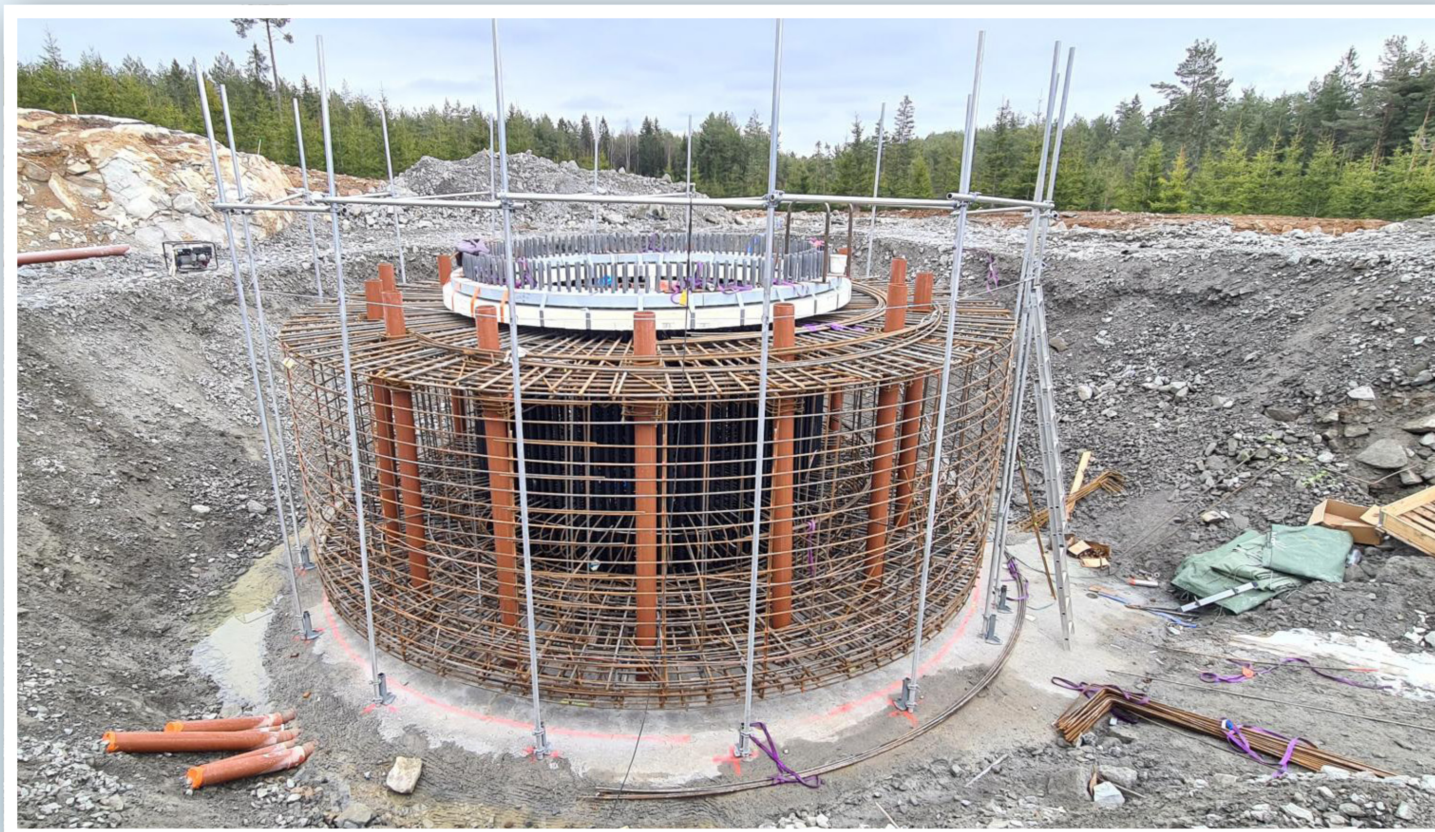
Pågående armering av gravitationsfundament
