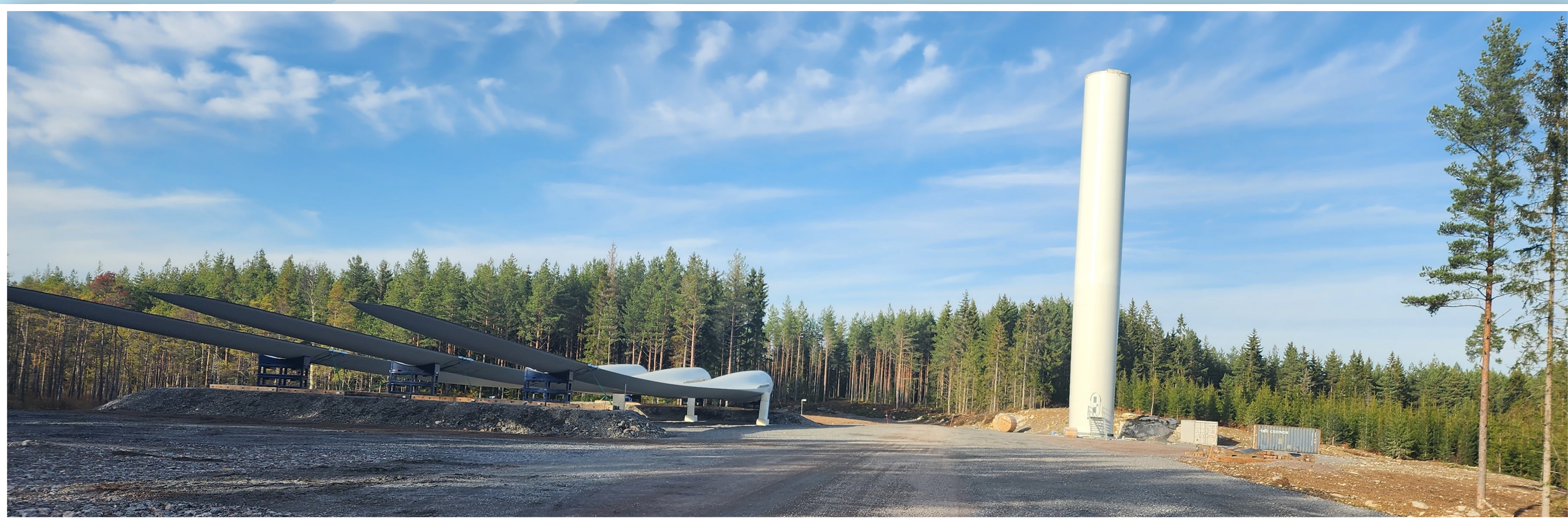
Vindkraftstorn i väntan på slutmontage
